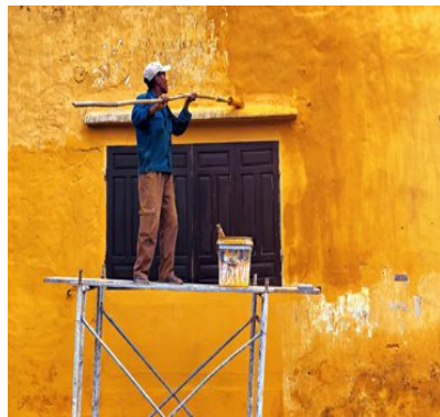
Abb. 1: Pedro streicht die Außenfassade des Gebäudes
