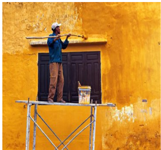
Abb. 1: Pedro streicht die Außenfassade des Gebäudes
